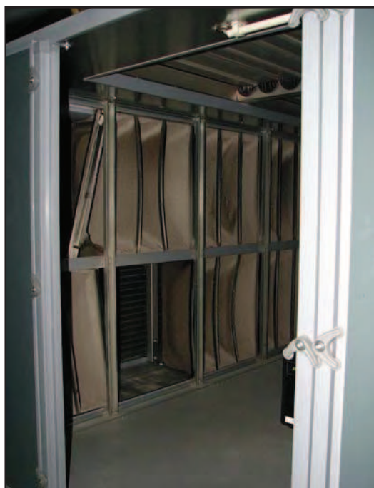
Fot. 3. Dezynfekcja komory filtracji promieniami
