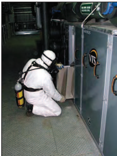
Fot. 1. Zdemontowany filtr powietrza
