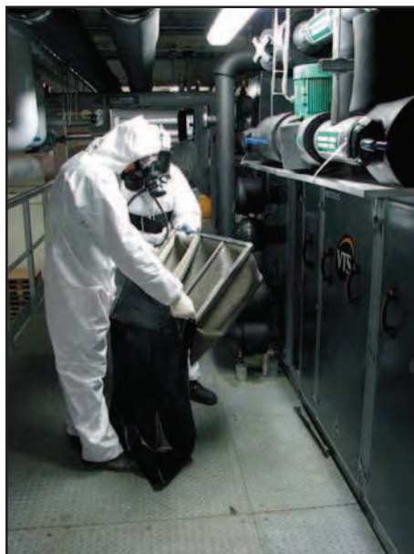
Fot. 2. Wymiana filtrów powietrza i dezynfekcja chemiczna centrali wentylacyjnej
