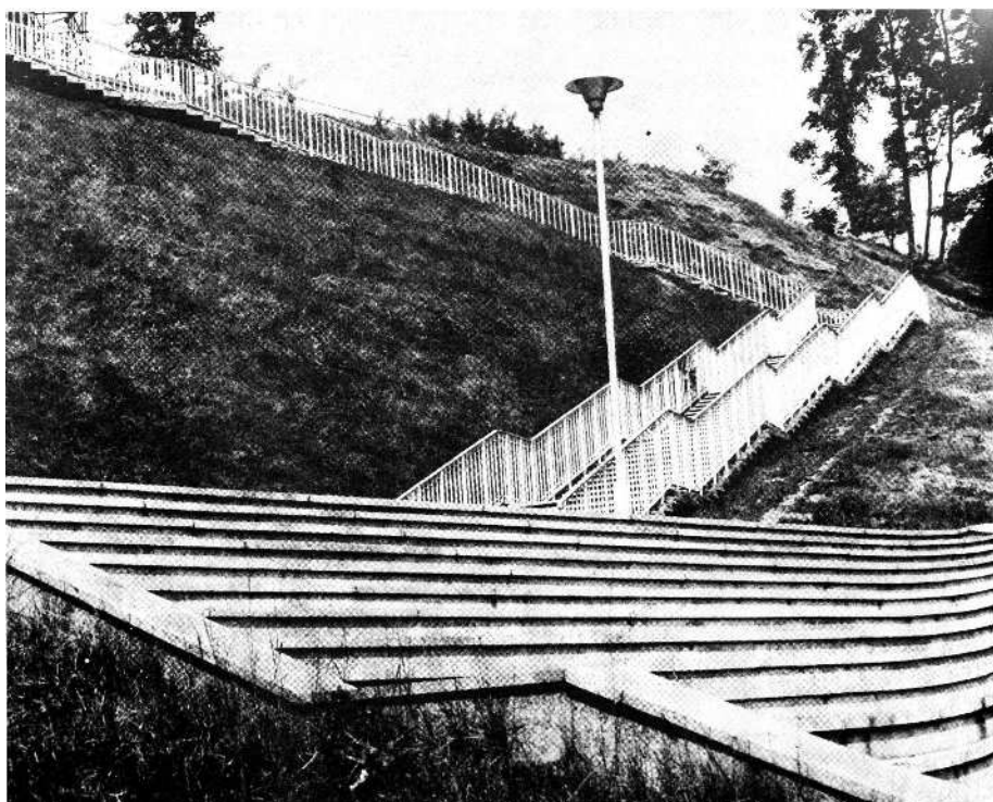
109. Schody na skarpie pod pałacem Ujazdowskim wg projektu L. Majdeckiego z roku 1974
