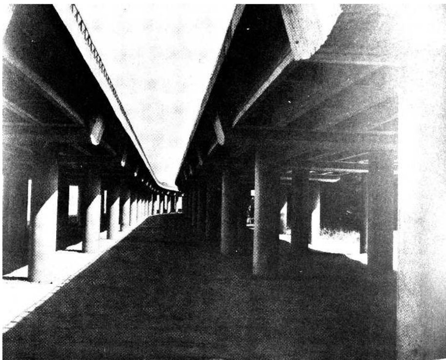
91. Estakada na Wislostradzie pod wzgórzem Bielańskim z toku 1975
