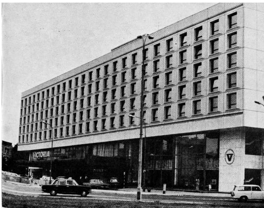
19. Hotel „Victoria” przy placu Zwycięstwa wg projektu D. Frazera, K. Hula, A. Dzierżawskiego, T. Pawelskiego i L. Sołoniewicza, otwarty w roku 1976
