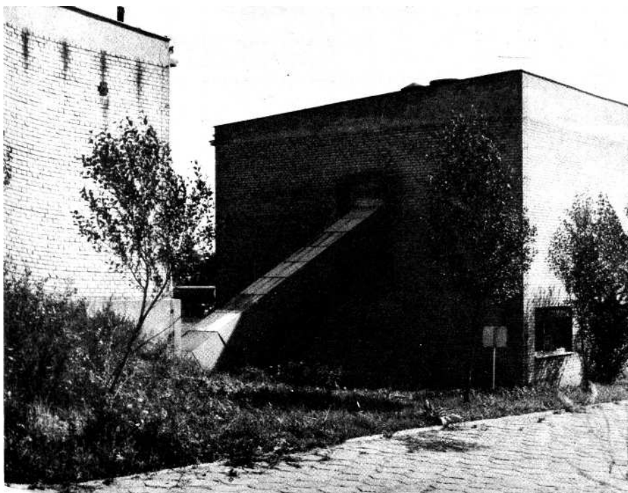
63. Kompostownia „Dano” (sita) uruchomiona w roku 1965 na Radiowie przy ulicy Kampinoskiej
