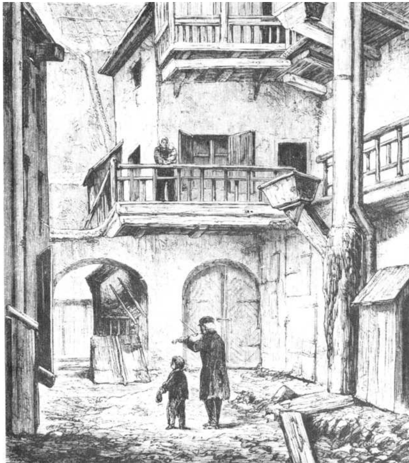
40. Drewniane zlewy i przewody kanalizacyjne stosowane przed wprowadzeniem kanalizacji Lindley-owskiej. Podwórko domu przy ulicy Podwale 523
