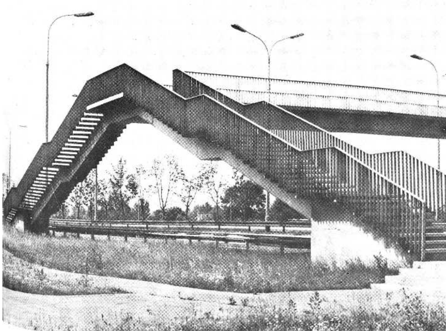
95. Kładka na Wisłostradzie na Bielanych z roku 1975
