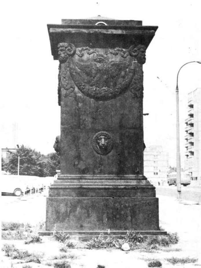
23. Jedna z dwu studzien (kopanych) na placu Krasieńskich, obudowa Ch. P. Aignera z roku 1823
