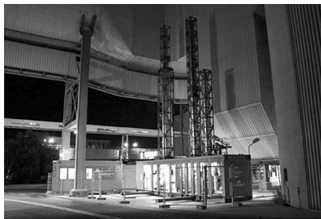
Rys. 2. Instalacja Pilotowa podczas nocnej kampanii badawczej na Elektrowni Łaziska
