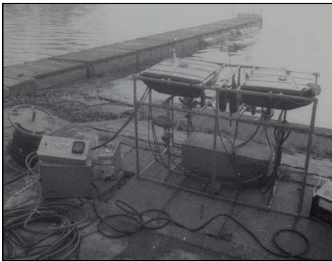
Rys. 3.1. Pojazd podwodny AITS w czasie prób nad Jeziorem Drawskim w 1982 roku [12].
