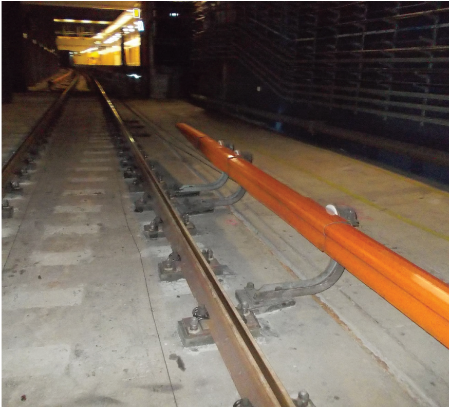
Rys. 7. Wjazd na stację A13 (Centrum) od strony stacji A14 (Świętokrzyska)
