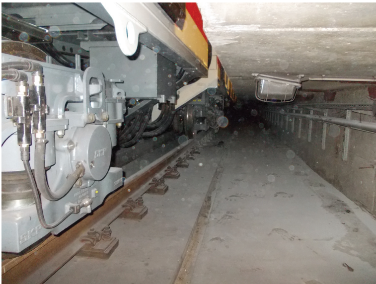
Rys. 4. Droga dojścia do uszkodzonego obszaru Źródło: opracowanie własne
