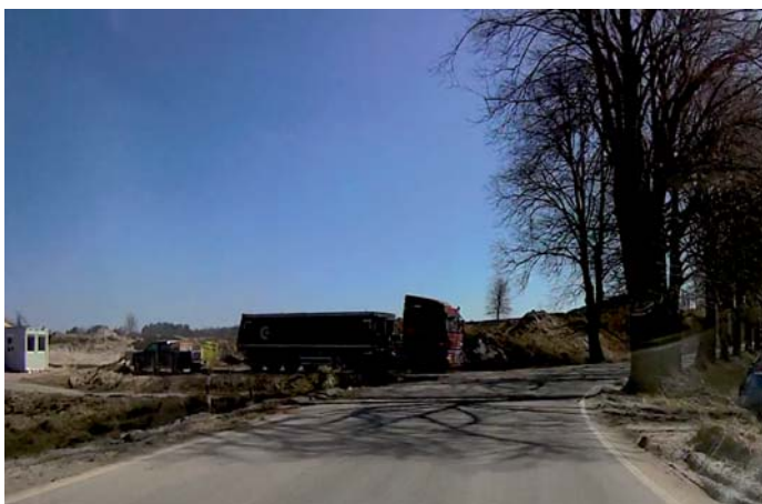
Fot. 1. Transport materiałów drogą powiatową przy budowie drogi krajowej
