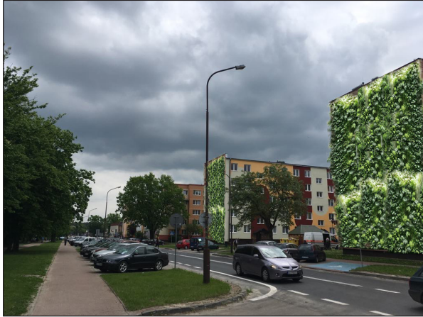
Fot. 5. Wizualizacja – Widok na zielone ściany bloków mieszkalnych przy Alei Niepodległości 17, 19 (fot. A. Ciastek) Photo 5. Visual. A view of the green walls of apartment blocks at Aleja Niepodległości 17, 19 (photo by A. Ciastek)
