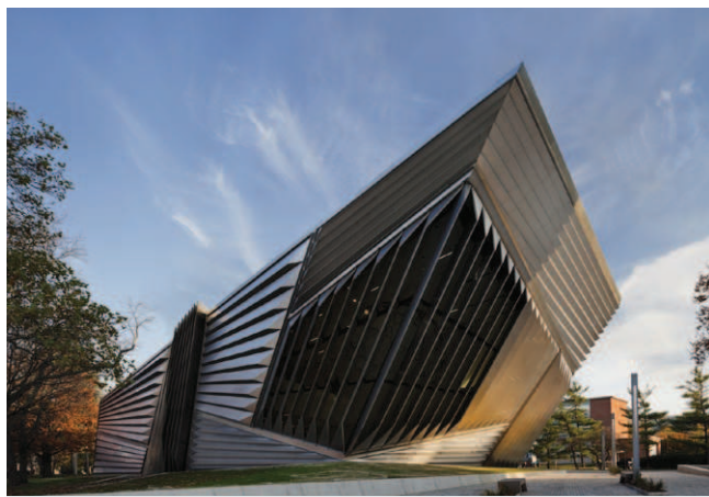
Rys. 5. Budynek Eli and Edythe Broad Art Museum w USA, w którym aluminium zastosowano jako materiał elewacyjny [7]
