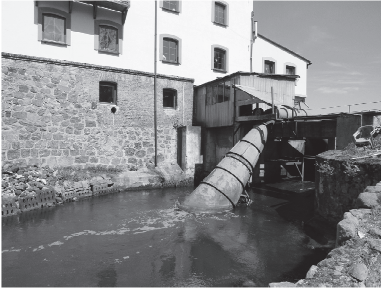
Fig. 4. Downstream view of SHPP at the Dobrzyca barrage on the Głomia river Rys. 4. Widok na dolną wodę MEW na stopniu Dobrzyca na rzece Głomi
