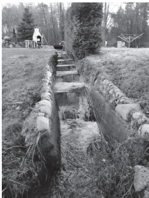
Fig. 5. Pool fish pass by Dobrzyca barrage on the Głomia river Rys. 5. Przeławka komorowa stopnia Dobrzyca na rzece Głomi
