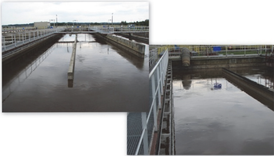
Rys. 3. Komora predenitryfikacji Fig. 3. Preliminary denitrification chamber
