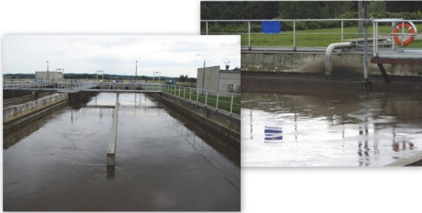
Rys. 4. Komora defosfatacji Fig. 4. Removing phosphorus chamber
