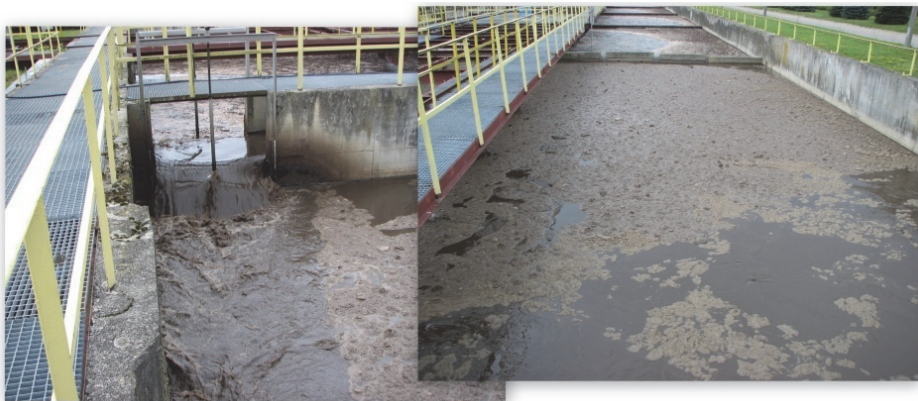
Rys. 7. Strefa denitryfikacji i kanał recyrkulacji wewnętrznej Fig. 7. Denitrification zone and internal recirculation channel
