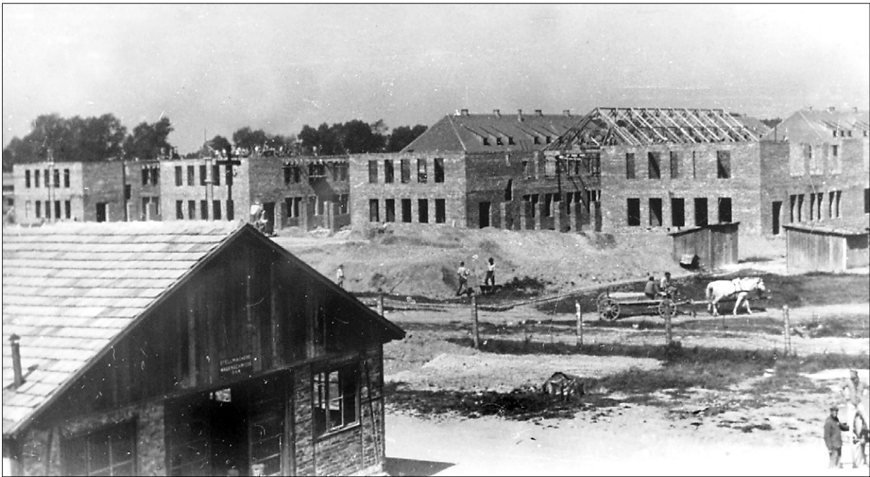
Ryc. 1. Jedno ze zdjęć rozbudowy KL Auschwitz I wykonywanych przez SS jako załączniki do sprawozdań budowlanych; w głębi widoczny zespół nowo wznoszonych bloków więziarskich Lagererweiterung, a także charakterystyczna konstrukcja wieszarowa więzarów dachowych oraz murowane z cegły ściany; źródło: APMA-B, opis na podstawie: M. Rawecki, Strefa Auschwitz-Birkenau , Gliwice 2003, s. 16.
