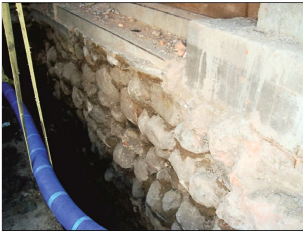
Ryc. 2. Widok fundamentu badawczego budynku zlokalizowanego w Olsztynie przy ul. Staromiejskiej: a) na zewnątrz budynku, b) wewnątrz budynku; fot. M. Zielińska 2012.
