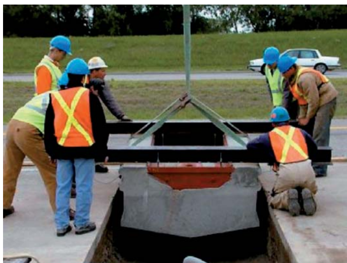
Fot. 4. Montaż wagi tensometrycznej (źródło: www.roadtraffic-technology.com )
