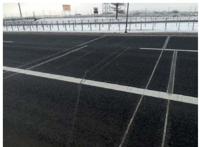
Fot. 2. Czujniki indukcyjne i czujniki nacisku wbudowane w jezdnię (źródło: materiały własne)
