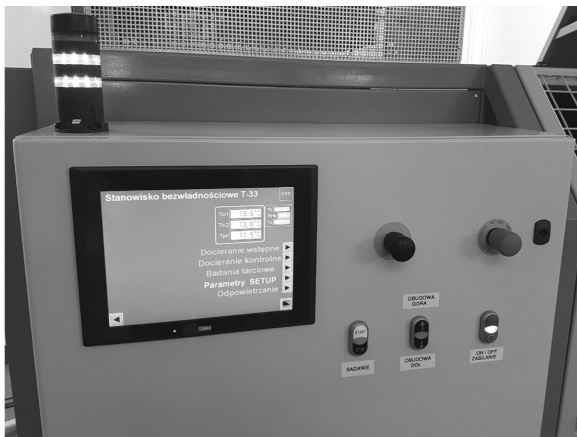
Fig. 4. Control cabinet integrated with the T-33 dynamometer Rys. 4. Szafa sterownicza stanowiska T-33
