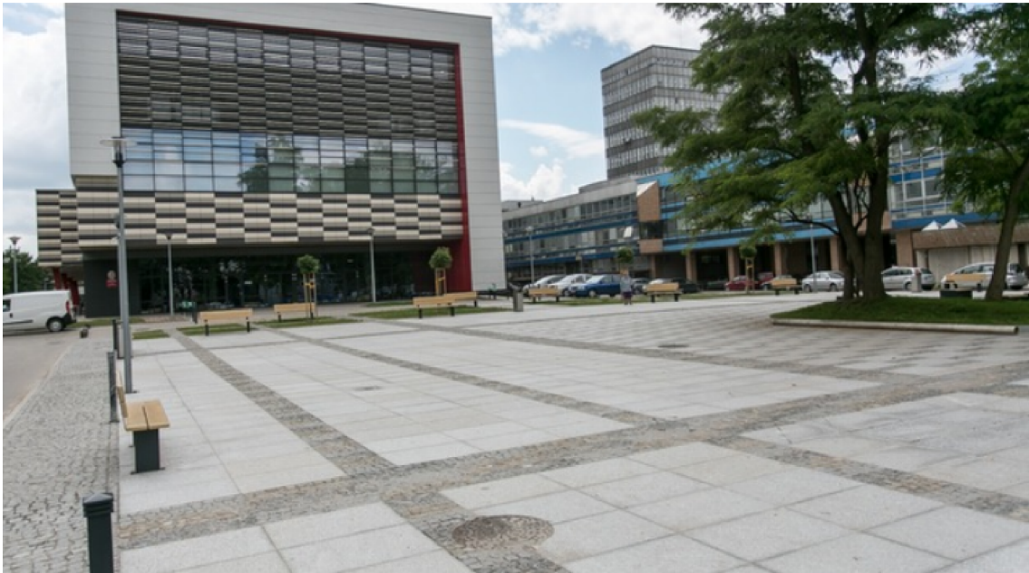
Budynek Wydziału Biotechnologii Uniwersytetu Wrocławskiego, fot. Tomasz Walków
