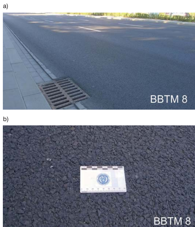
Fot. 2. Ulica Wołoska w Warszawie z nawierzchnią o obniżonej hałaśliwości BBTM: a) widok ogólny b) makrotekstura
