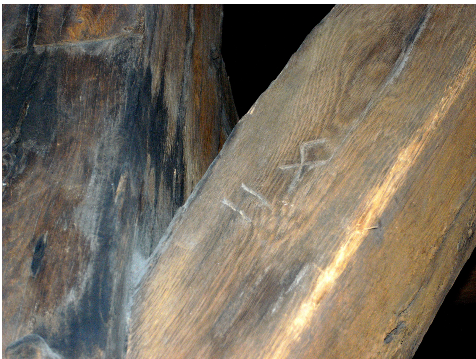
Ryc. 3 Znak ciesielski na elemencie więźby dachowej katedry Notre Dame, fot. D. Mączyński 2009 r.
