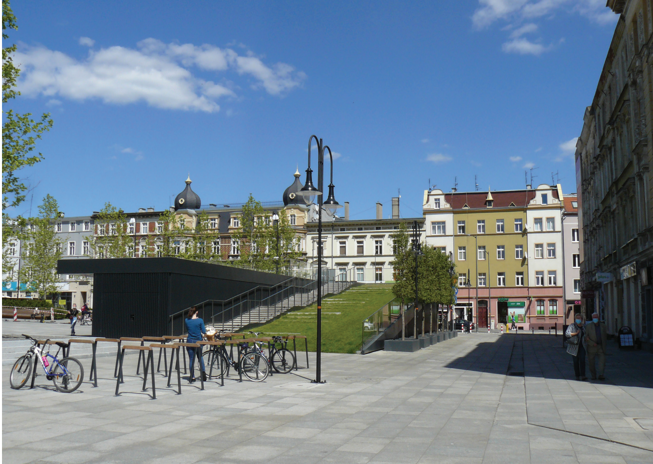
Rys. 8. Plac Mikołaja Kopernika po przebudowie w latach 2017–2019. Pawilon wjazdowo-wejściowy z tarasem widokowym łączący podziemny parking z powierzchnią placu wraz z rampą o nawierzchni z darni, źródło: fot. M.E. Adamska (2020)
