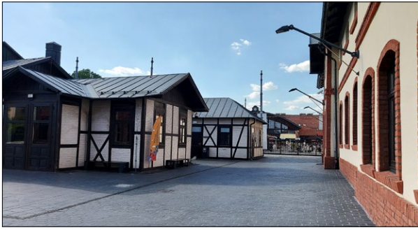
Ryc. 3. Uliczka prowadząca do Muzeum w hali D z widokiem na plac przed restauracją Stara Zajezdnia w hali K, 2022; fot. M. Wdowiarz-Bilska.
