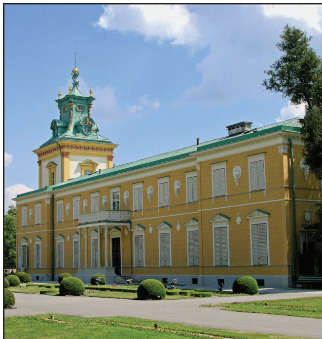
Rys. 10. Odrestaurowana elewacja północna skrzydła północnego
