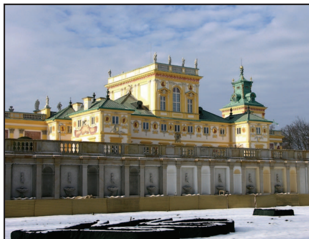
Rys. 6. Elewacja pałacu od ogrodu w nowej szacie kolorystycznej Fig. 6. The façade of the palace from the garden in the new color outfit
