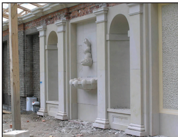
Rys. 12. Fragment muru oporowego w trakcie prac konserwatorskich Fig. 12. Fragment of retaining wall during the conservator's works
