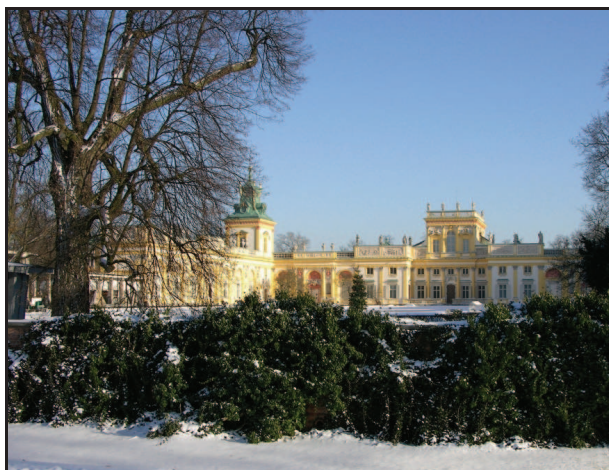
Rys. 5. Elewacja pałacu od dziedzińca w nowej szacie kolorystycznej Fig. 5. Façade of palace from the piazza in the new color outfit
