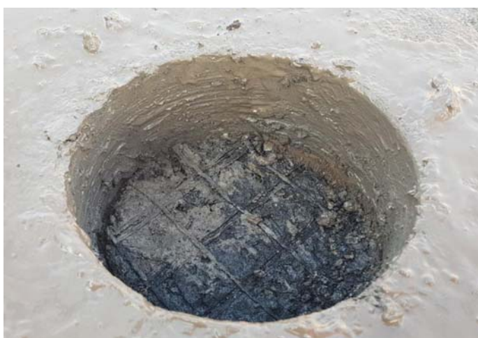
Fot. 1. Zdjęcie odwiertu kontrolnego w pasie wzmocnionym ukazujące siatkę z włókna szklanego (materiały własne)
