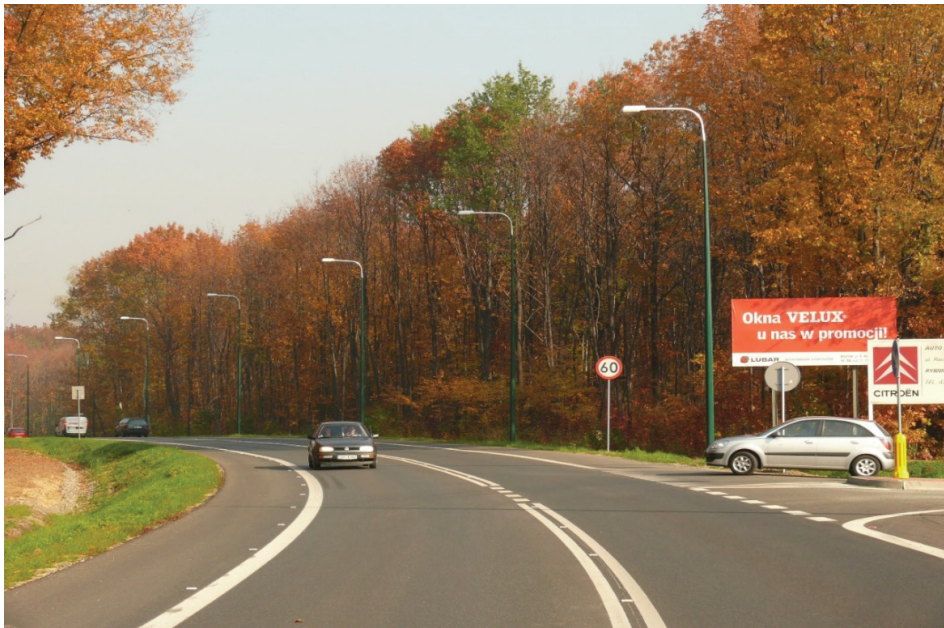
Rys. 7. Bezpieczne słupy kompozytowe nie wymagają stosowania barier ochronnych
