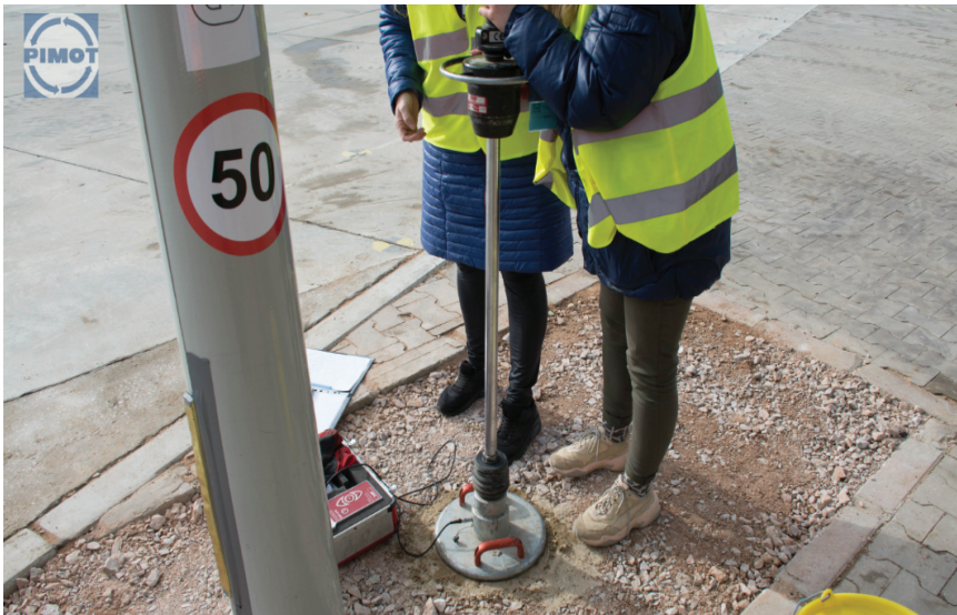
Rys. 3. Badanie stopnia zagęszczenia warstwy zasypki wokół słupa. Badanie wykonuje się dla każdej zagęszczonej warstwy, co 30 cm wg wymagań normy [7]
