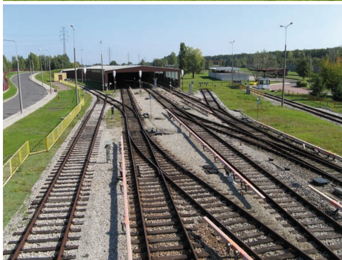
STP Kabaty, w tle widoczny wjazd do tunelu metra (3 tory), 23.09.2006 r.
