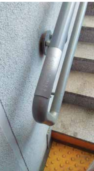
Oznakowanie numeru peronu i oznaczeń kierunkowych na poręczy schodów prowadzących na peron dworca Łódź Widzew. W tle kontrastowe i dotykowe oznakowanie początku schodów
