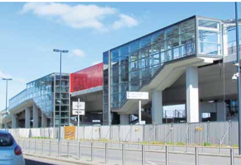
Gdańsk Port Lotniczy, Przystanek PKM w budowie 11.05.2015 r. Fot. R. Stankiewicz
