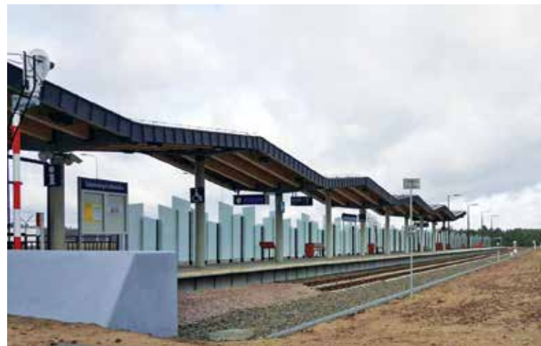
Szymany stacja kolejowa portu lotniczego. Fot. R. Janczewski
