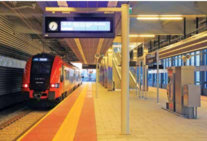
Stacja kolejowa w porcie lotniczym Kraków Balice. Fot. M. Wojtaszek
