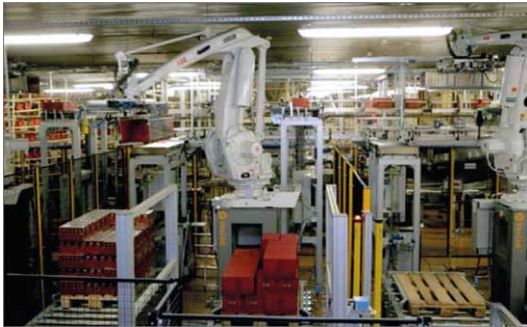
Rys. 13. Stanowisko do paletyzacji kawy w firmie Strauss Cafe Poland (Źródło: ABB)
