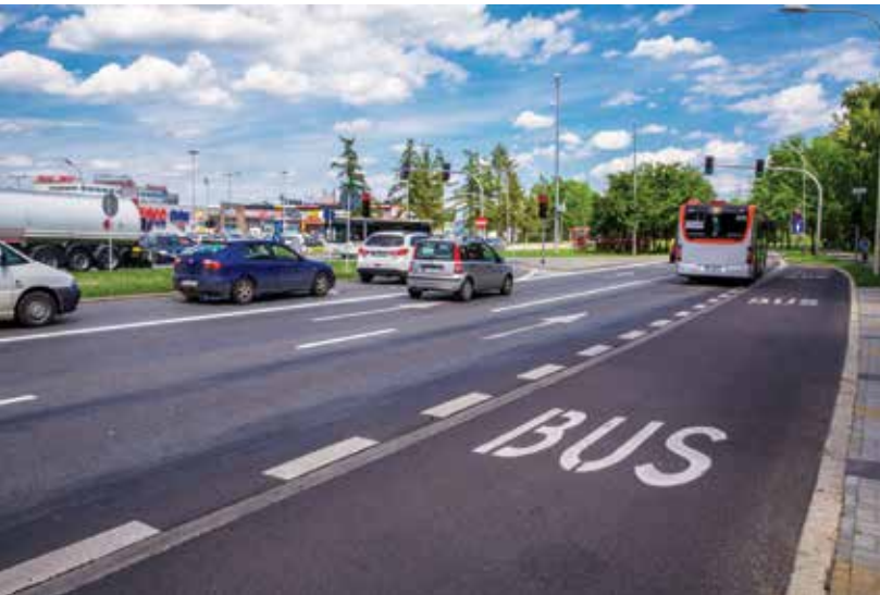
Przebudowa układu drogowego pozwoliła na wydzielenie w centrum Rzeszowa ok. 6 km buspasów
