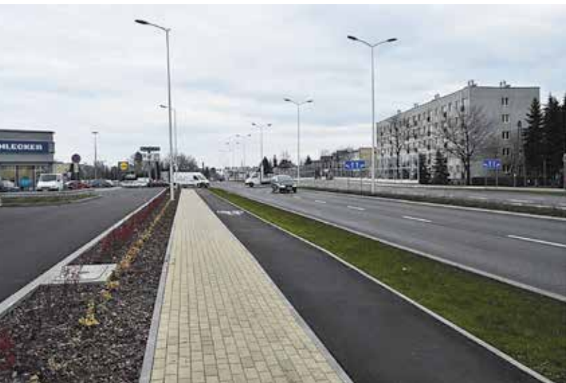
Przebudowie dróg towarzyszyła budowa ścieżek rowerowych
