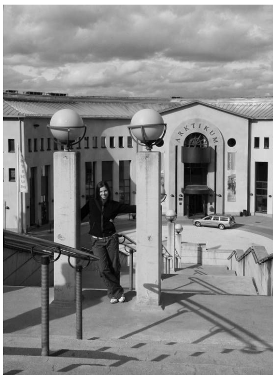
Fot. 9. Przy projektowaniu Ośrodka Nauk Arktycznych autorzy sięgnęli do repertuaru form postmodernistycznych. Elewacja wejściowa została wzniesiona na planie wklęsłego łuku, otaczającego zagłębiony w ziemi, reprezentacyjny plac. Zdjęcie autora.
