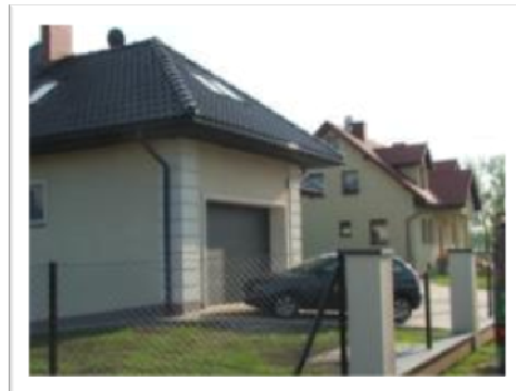
Fot. 2. Zabudowa jednorodzinna. Źródło: Fot. Autora. Pic. 2. Single-family houses. Source: Fot. author.
