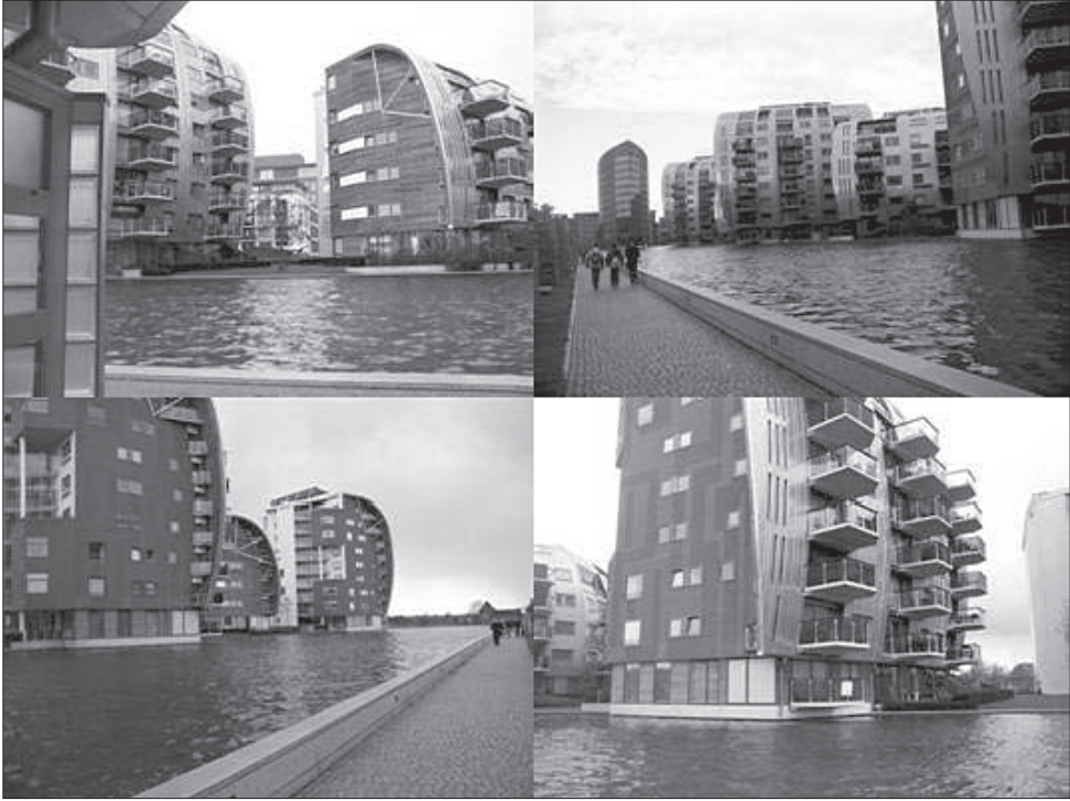
Fot. 1. Projekt „ARMADA” zrealizowany w centrum biznesowo-mieszkalnym w mieście Herto-genbosch w Holandii. Kompleks zaprojektowano w nastroju holenderskich kanałów, z częścią balkonów nad samą wodą. Widoczny jest sztuczny zbiornik wodny (długości ok. 300 m i głębokości ok. 30 cm) z systemem kojąco szumiących fontann i przepływającą wodą. Przyjazny dla ludzi projekt przyciąga także odpoczywające ptaki. (fot. J. Kostecka)
