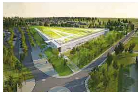
5. Centrum Konserwacji i Magazynowania paryskiego Luwru w Liévin, proj. Rogers Stirk Harbour + Partners, https://www.dezeen.com/2015/07/07/rogers-stirk-harbour-partners-conservation-storage-facility-musee-du-louvre-lievin-paris-france/
