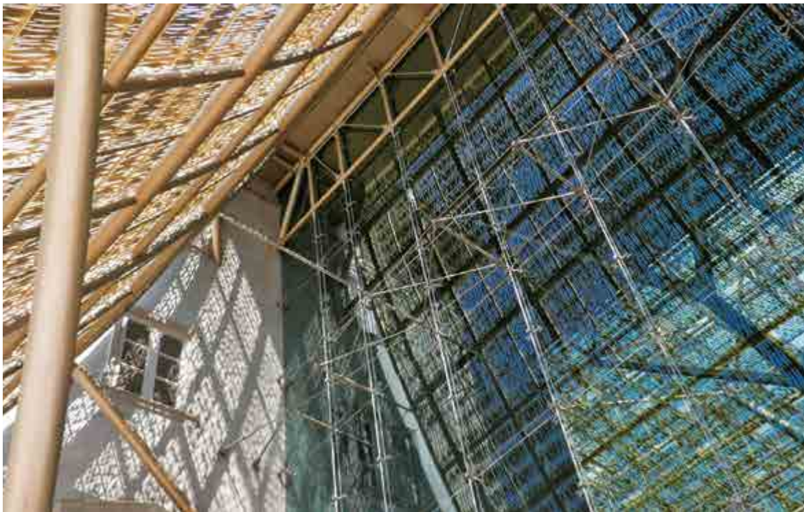
4. Koronkowa przegroda nad wejściem głównym do Singapore National Gallery – „welon” osłaniający przed słońcem hall utworzony pomiędzy zabytkowymi budynkami
