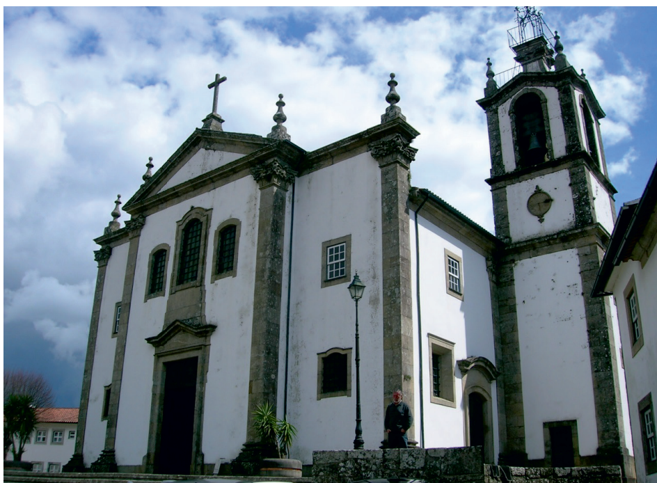
Fot. 6. Valença do Minho – charakterystyczna zabudowa sakralna (fot. J. Kukulak)
