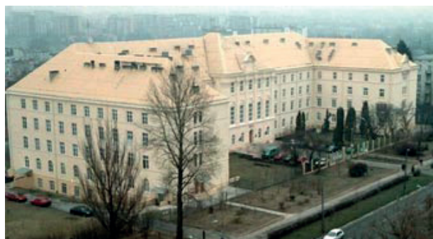
Zdjęcie 4. Szpital z lewym skrzydłem dobudowanym w 1985 roku [14].
