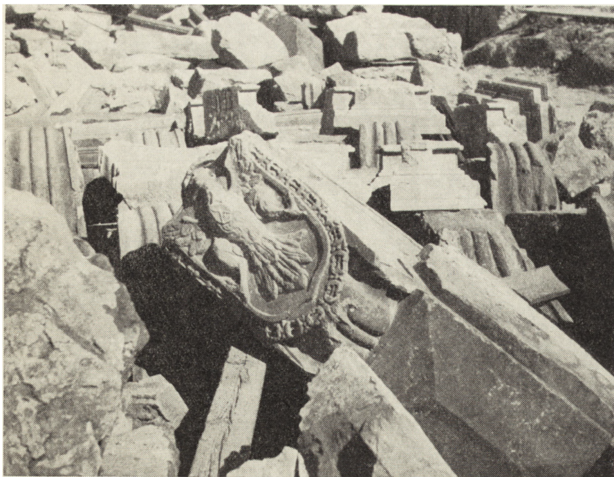
4. Zamek Królewski w Warszawie, fragmenty dekoracji architektonicznych elewacji wschodniej (fot. E. Kupiecki, 1951)
