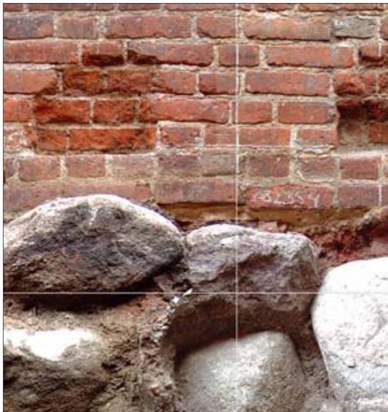
12. Gdańsk, Centrum Dominikańskie. Ortofotografia lica muru w piwnicy kamienicy przy ul. Szerokiej 115. Dobrze technicznie wykonana ortofotografia pozwala rejestrować obraz rzeczywisty z możliwością oglądania go w dużych zbliżeniach. Jest zatem najlepszym sposobem rejestrowania stanu zachowania badanego obiektu. Wyk. S. Tyszczyk.
