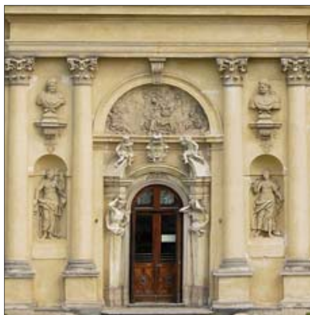
7. Wilanów. Fragment południowej elewacji skrzydła północnego, detal. Ortofotografia. Wyk. K. Czajkowski i M. Gładki.
