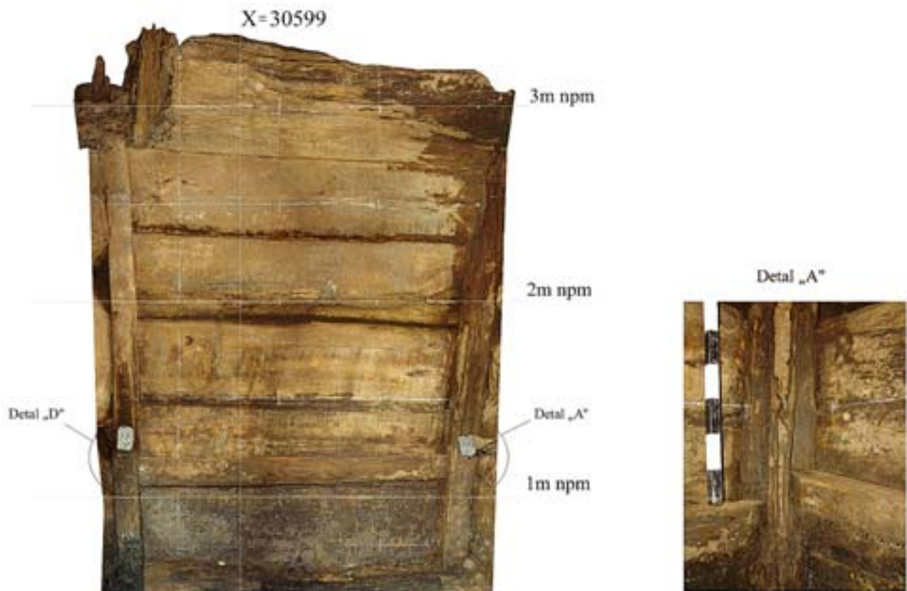
9. Gdańsk, Centrum Dominikańskie. Ortofotografia lica wewnętrznego drewnianej, średniowiecznej latryny jest dowodem na możliwość zastosowania metody w warunkach ekstremalnie trudnych. Wyk. S. Tyszczyk.
