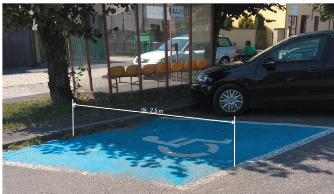
Fot. 4. Widok zbyt krótkiego miejsca postojowego dla osób niepełnosprawnych zlokalizowanego na obszarze 1 SPP (stan na lipiec 2018) [zasoby własne]
