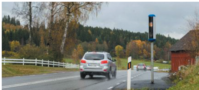
Fot. 1. Przykład urządzenia do nadzoru nad prędkością w Szwecji Źródło: [25]
