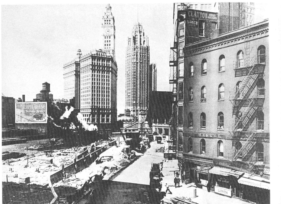
Budowa drogi szybkiego ruchu - Wacker Drive w 1923 r.
