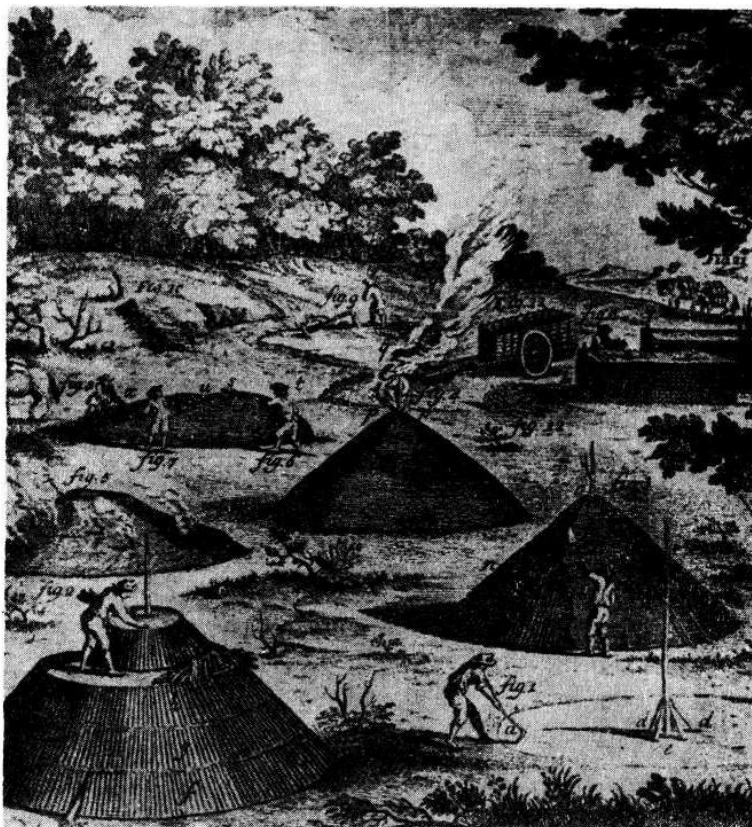
2. Mielerze — przygotowywanie węgla drzewnego do wytopu żelaza (sztych)
