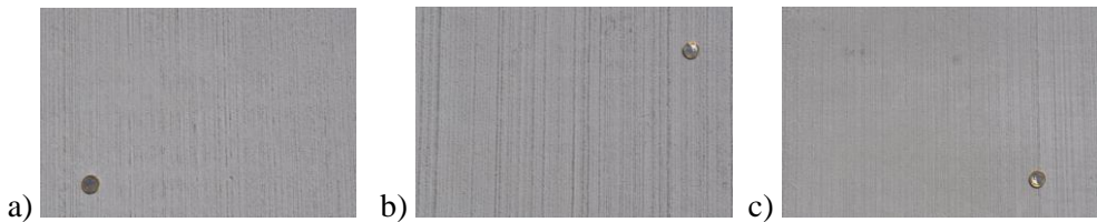
Rys. 4.7. Widok nawierzchni betonowej w przekrojach: a) CC1, b) CC2, c) CC3
