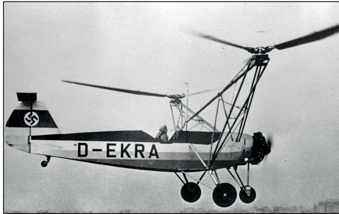
Rys. 1.8. Pierwsza udana konstrukcja śmigłowca – Focke-Achgelis Fa 61 [fot. wikipedia.org]
